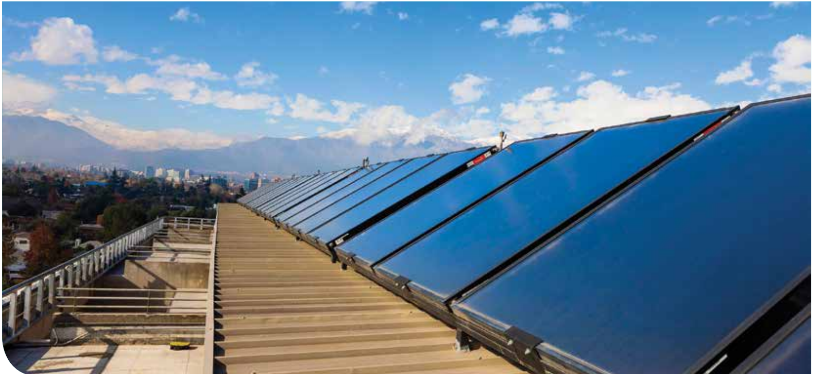
Paneles Solares de Clínica Alemana
